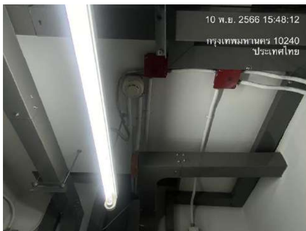
เครื่องตรวจจับความร้อนภายในห้อง MDB
