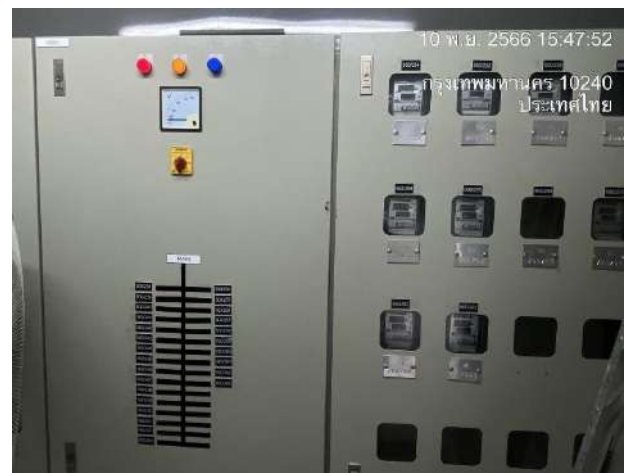
สวิตช์เปิด-ปิดไฟฟ้าส่องสว่างภายในอาคาร
