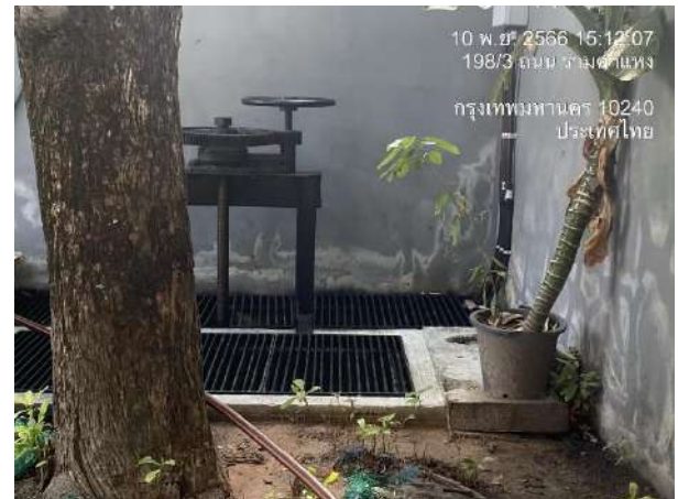
ภาพที่ 2-23 ตะแกรงครอบท่อพักน้ำสุดท้าย
