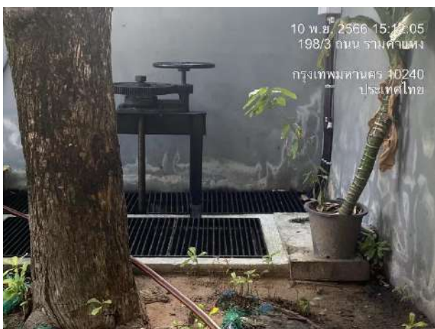
บ่อพักน้ำสุดท้ายพร้อมตะแกรง
