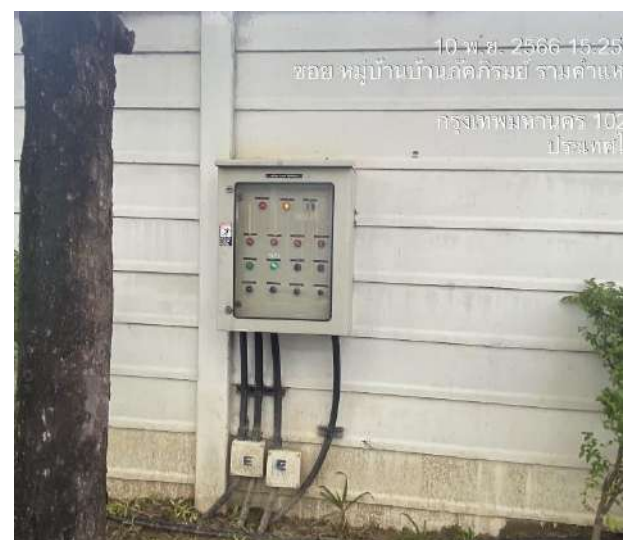
ตู้ควบคุมของระบบบำบัดน้ำเสีย A 2
