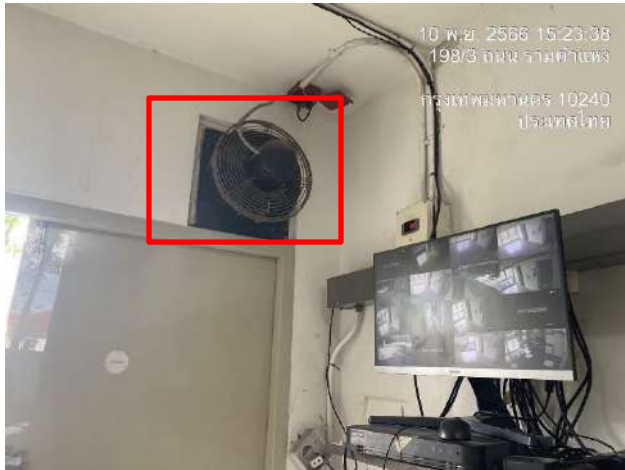
พัดลมดูดอากาศภายในห้อง MDB
