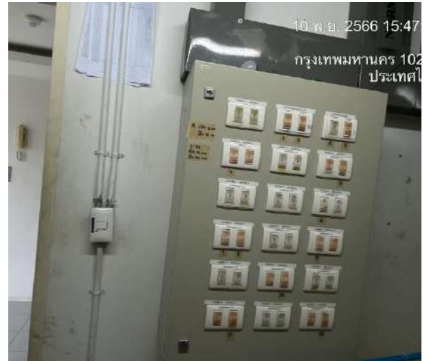
สวิตช์เปิด-ปิดไฟฟ้าส่องสว่างภายในอาคาร
