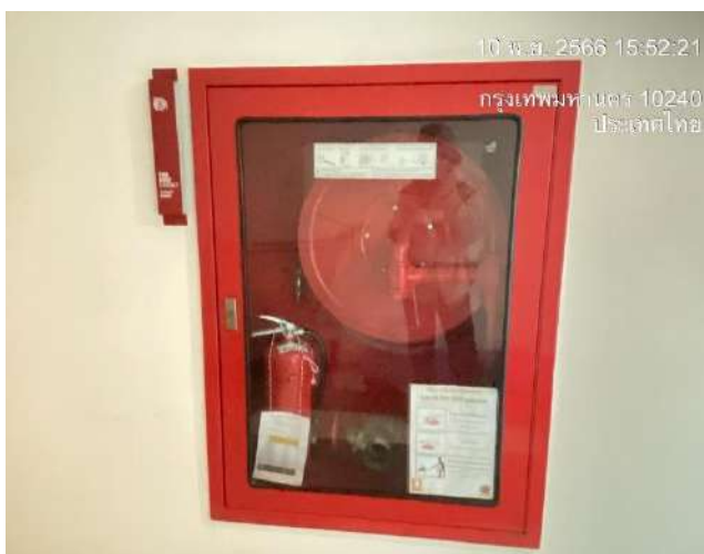
ตู้เก็บสายฉีดน้ำดับเพลิงและอุปกรณ์ดับเพลิงพร้อมป้ายแสดงวิธีการใช้
