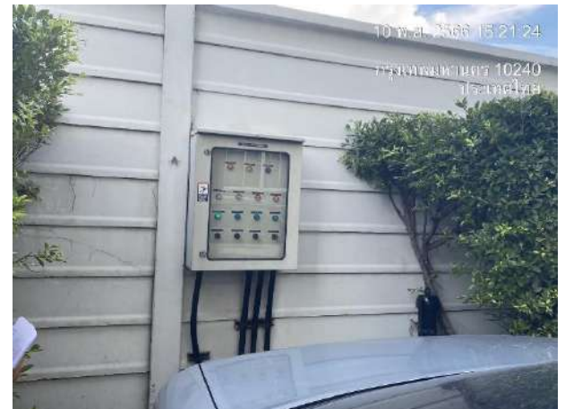
ตู้ควบคุมของระบบบำบัดน้ำเสีย A 1
