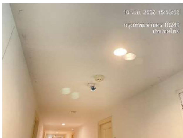
ไฟฟ้าส่องสว่างและเครื่องตรวจจับควันภายในอาคาร
